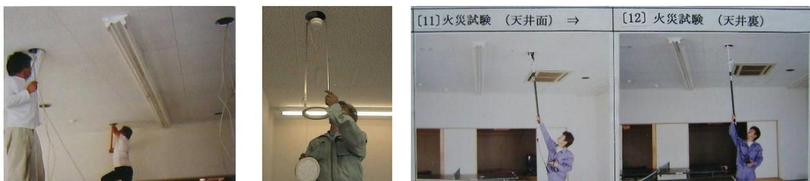
〔天井裏配線(入線工事)〕 〔金物天井挿入〕 〔火災試験(天井面)〕 〔火災試験(天井裏)〕
