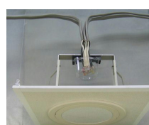
〔天井裏配線接続〕
