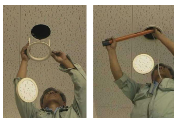
〔現場取付／現場入線〕
