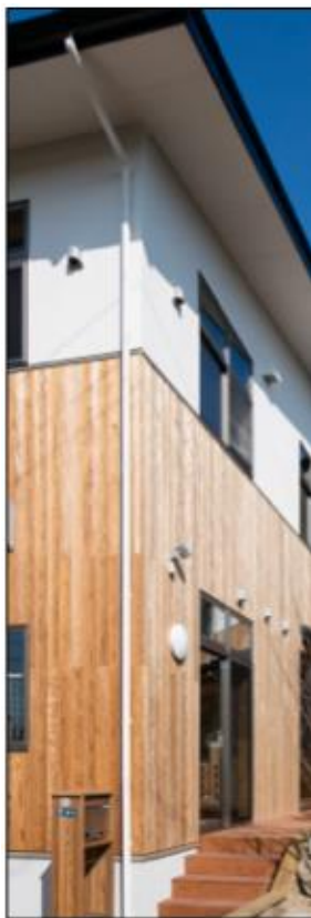
サーモサイディング施工例
